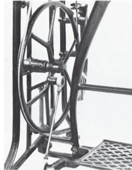
Abb. 5.19: Nähmaschinen- antrieb
