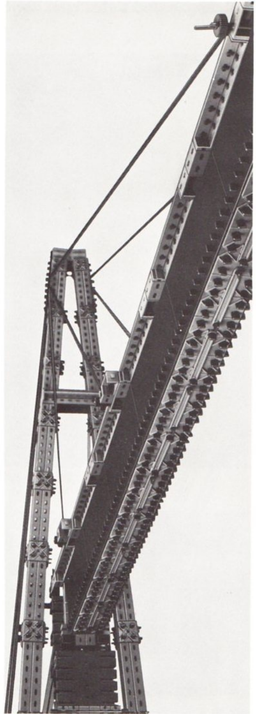
Abb. 31 Die fertige Schrägseilbrücke von unten aufgenommen. Deutlich ist hier die Verriegelung des Untergurts mit Doppelknotenplatten und Streben 75 zu sehen. Am Obergurt erkennt man gut die zwischengesteckten Winkelträger 30 und auch die Sperrvorrichtungen.
