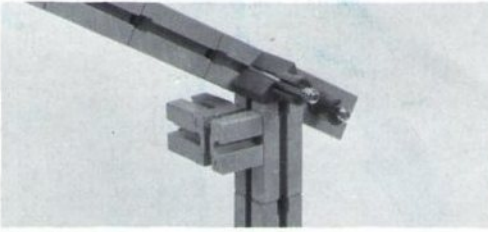
Abb. 3.9.7 Lagerung des Signalfügels am Mast.
