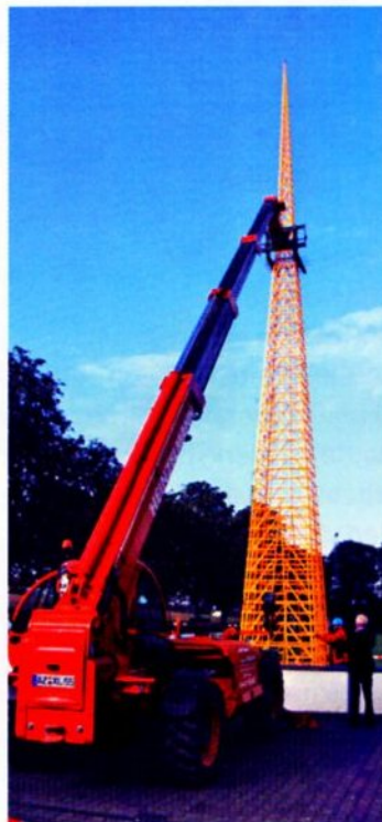
Die Montage des Turms von Michael Stratmann
