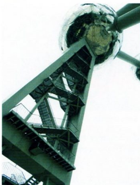
Detail van het trappenhuis dat verwerkt zit in de steun van elke buitenste bol. Eigen foto; zomer 2013.
