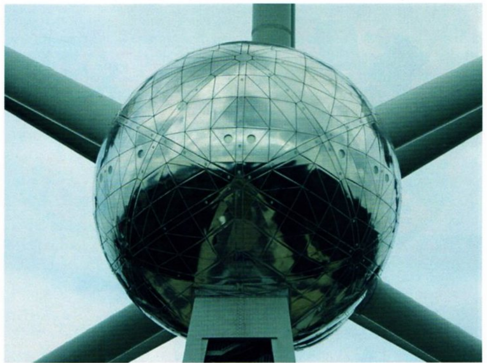
Elke bol heeft 12 vierhoeken, 8 zeshoeken en 6 achthoeken die in symmetrie met elkaar verbonden zijn. Eigen foto; zomer 2013.
