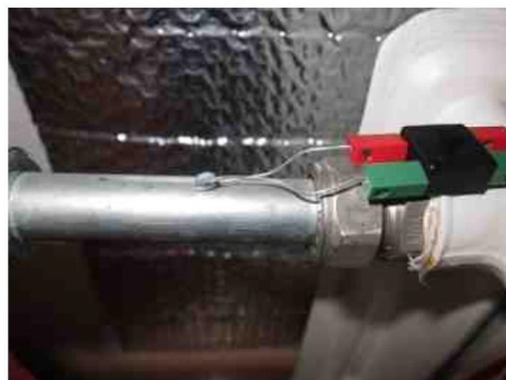
Figuur 7 Montage op invoer cv
