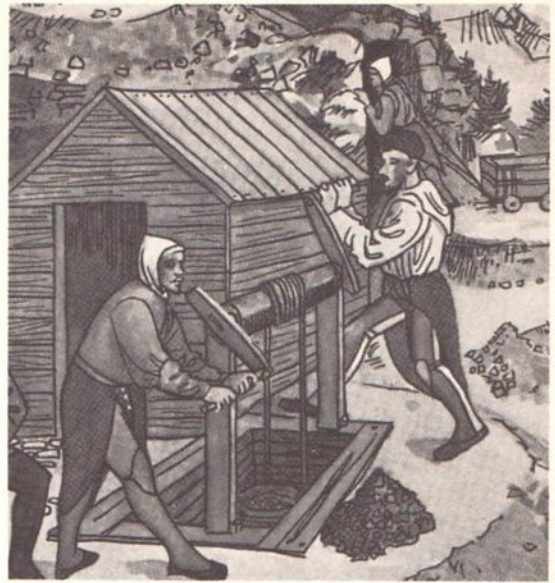
Abb. 12 Zeichnung zur Treibscheibenförderung (Quelle vgl. Abb. 9).
